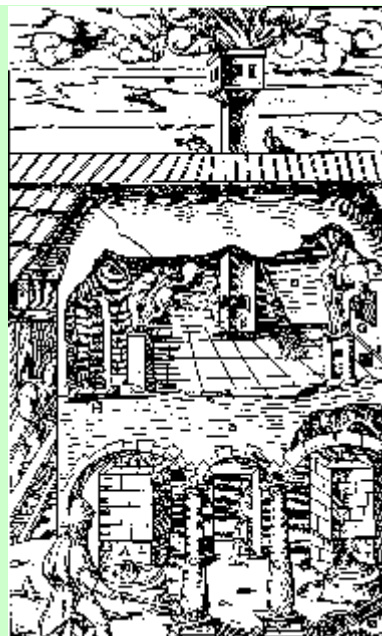
Riduzione dei minerali nei forni a manica
